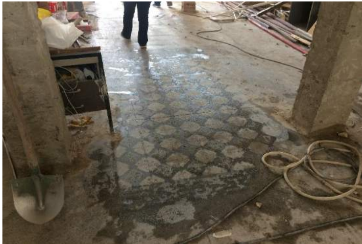
Şekil 13: Karo Mozaik Döşeme Kaplamalarının Onarılması
