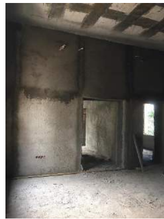
Şekil 11: Çelik Hasır ve Püskürtme Beton Uygulaması
