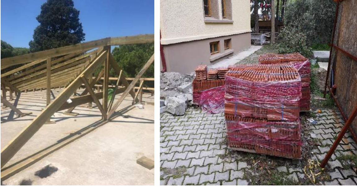
Şekil 16: Ahşap Oturtma Çatı ve Marsilya Kiremit
