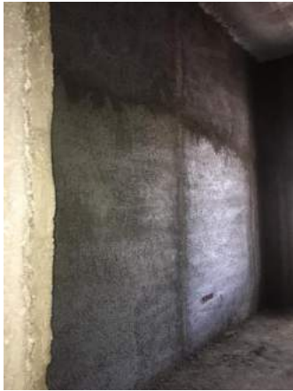
Şekil 11: Çelik Hasır ve Püskürtme Beton Uygulaması
