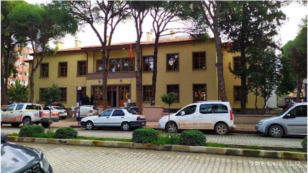
Şekil 17: Onarım ve Güçlendirme Çalışmalarının Ardından Burhaniye Hükümet Konağı
