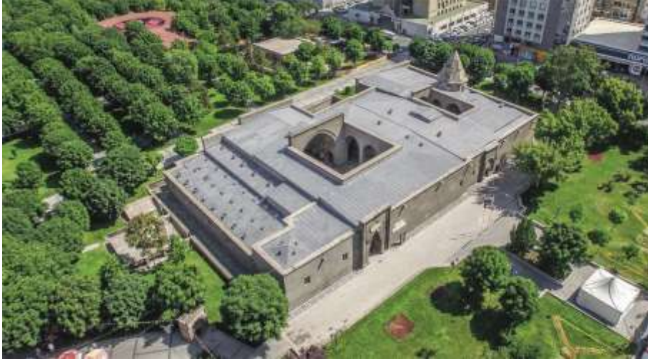
Görsel 5: Şifahiye Ve Giyasiye Medresesi Durumu (11)
